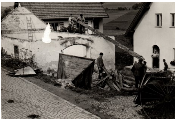
Abbruch des alten Gerätehauses
