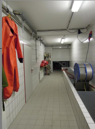
Zugang zum Schlauchturm
