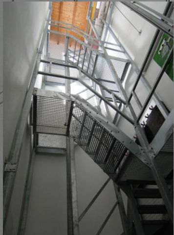
Aufstieg durch Schlauchturm
